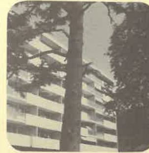
Vitrages Bât. Locatif
